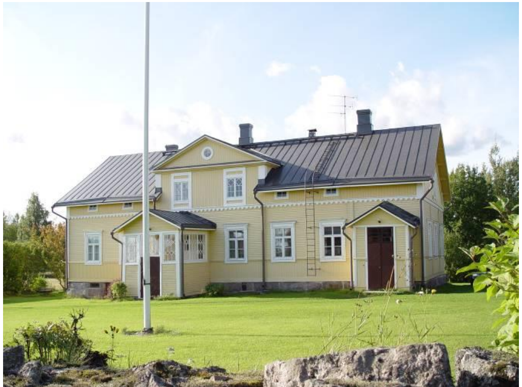
Kuva: Vanhaa rakennuskantaa Kirkonkylässä, Kolkkala.
