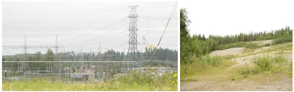
Kuvat: Vasemmalla Hikiän muuntamoasema. Oikealla vanha hiekanottoalue Kupparinlamminmäen etelärinteellä.
