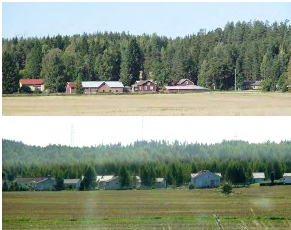
Kuvat: Vanhaa ja uutta rakennuskantaa pellon reunassa. Maisemakuvassa reunavyöhykkeiden ilme on merkittävä. Vyöhykkeellä suojapuuston käyttö on tärkeää ja kulttuurihistoriallisesti arvokkailla alueilla myös rakennusten sovittamiseen alueen perinteiseen rakennuskantaan tulee kiinnittää huomiota. Kajannon tila sekä uusi asuinalue Hikiän taajaman pohjoisosassa.
