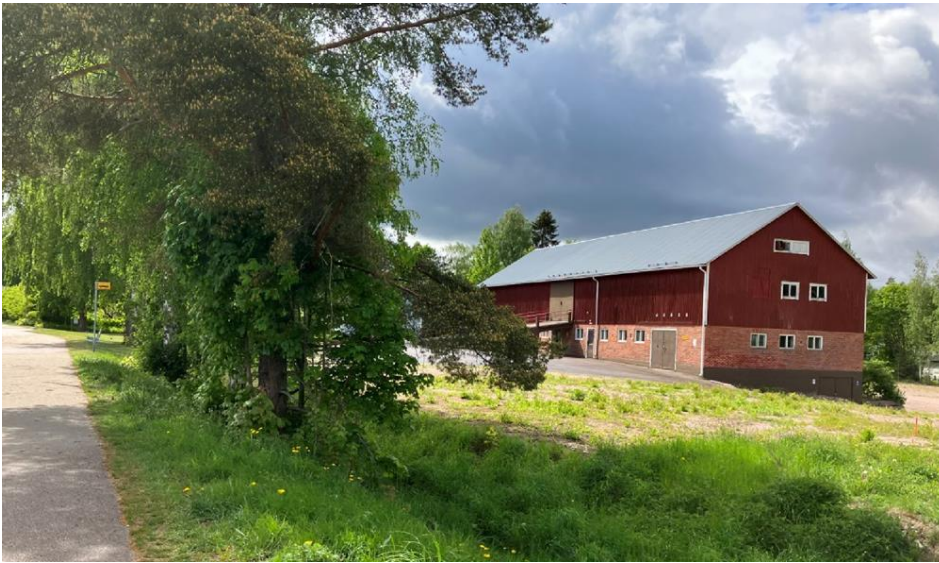
Kuva 6 Suunnittelualueella sijaitseva navettarakennus.
