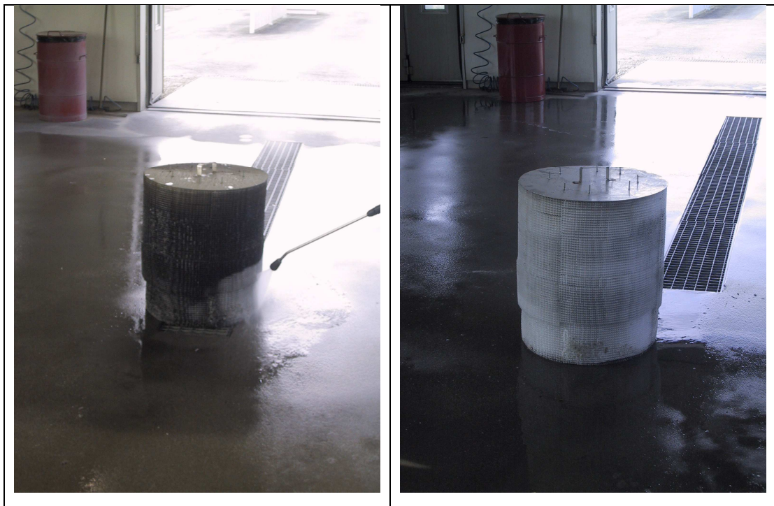
Kuva 8. Koalisaattorin puhdistus painepesurilla ja koalisaattori puhdistuksen jälkeen.
