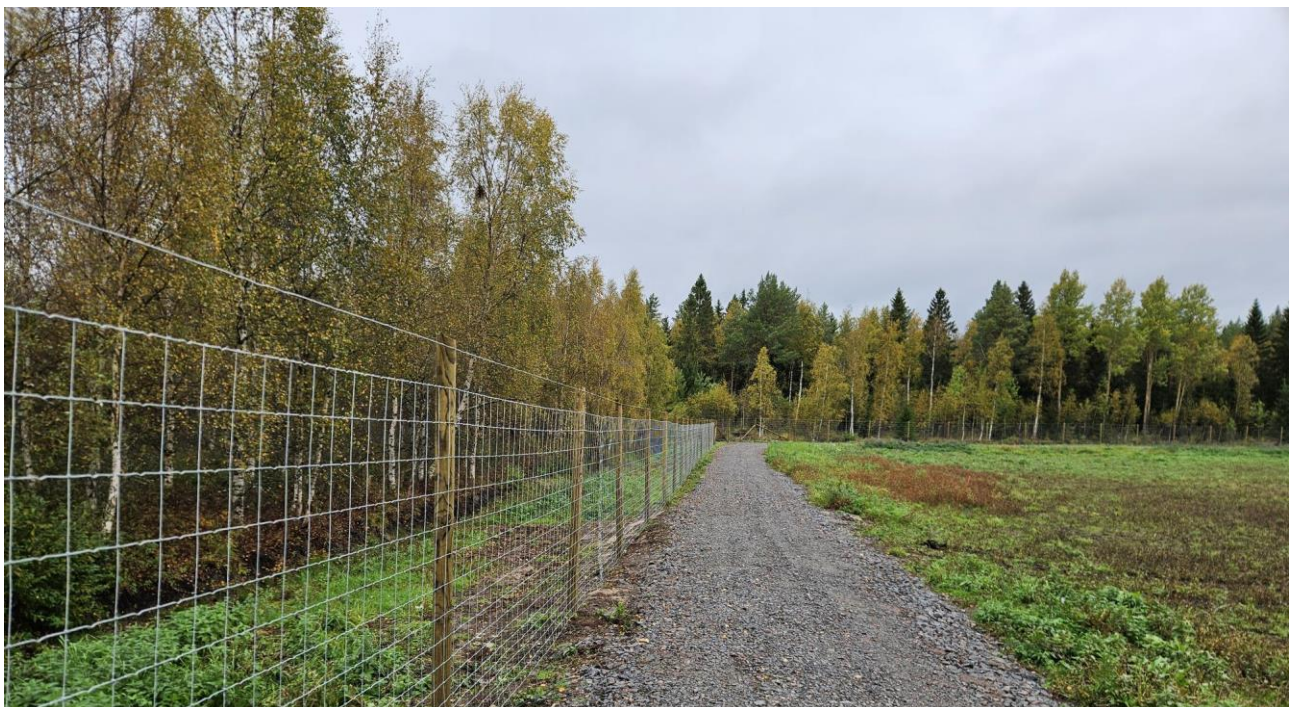
Kuva 2. Hankealue aidataan riista-aidalla. Kuva: Oomi Solar Oy.
