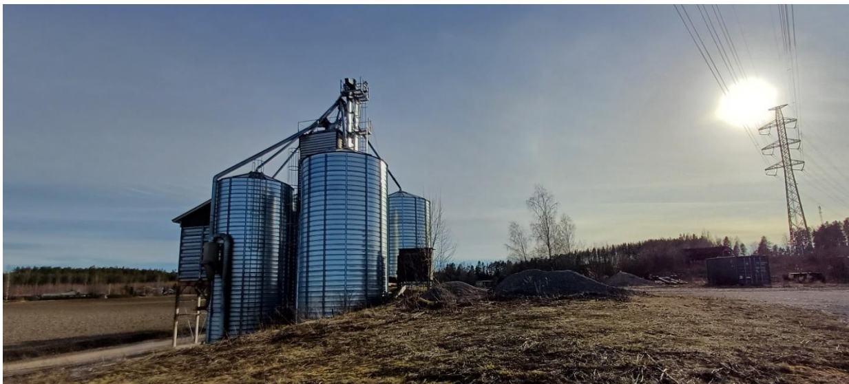
Kuva 11. Hankealueen eteläpuolen läntisessä saarekkeessa on iso kuivurirakennus ja voimajohdon pylväitä. Kuvattu lounaaseen päin. Kuva: Paula Salonen, Envineer Oy.
