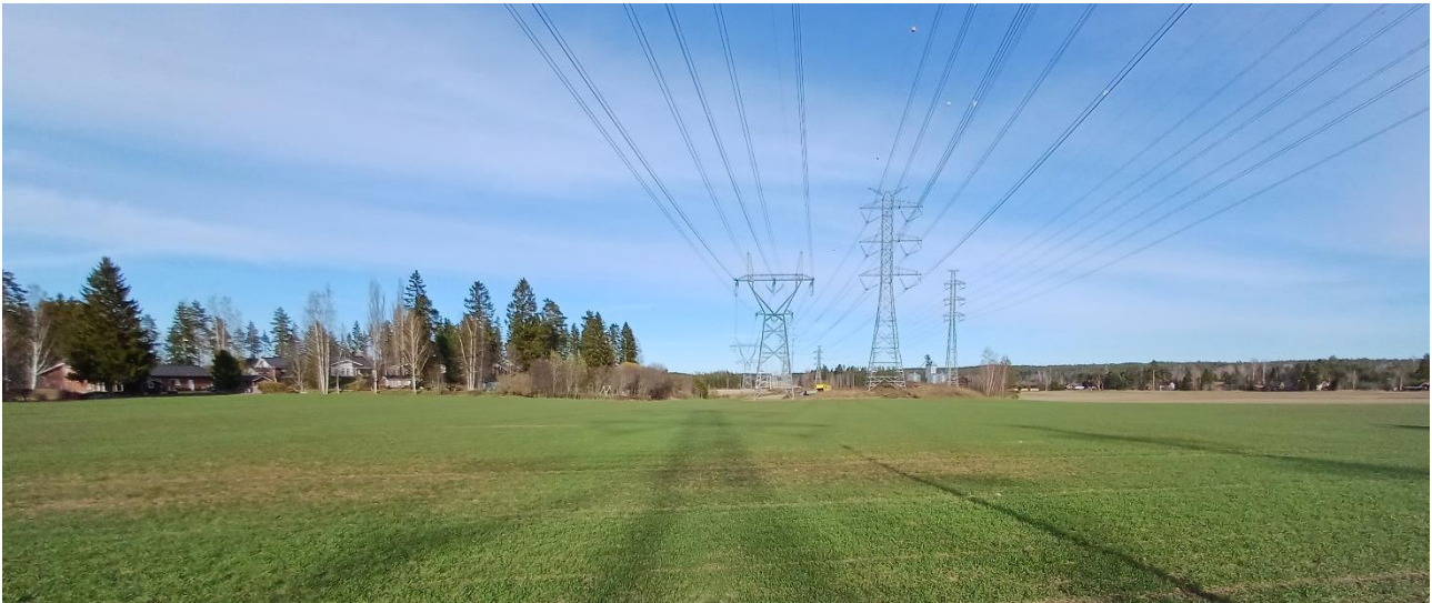
Kuva 13. Maisema kuvattuna Hikiäntieltä hankealueelle päin. Keskellä näkyy hankealueen eteläpuolella oleva saareke, jossa on kuivurirakennus ja voimajohtojen pylväitä. Saarekkeen ja viereisen asuinalueen metsän välillä on kapea kaistale peltoa. Kuva: Paula Salonen, Envineer Oy.
