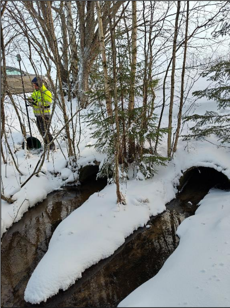
Kuva 4 Monninlinjan nykyisellään alittavat 2*800B rummut Erkylänlukkojenpurossa sekä Monninlinjan tien varresta purkava 400M rumpu (kuva: J. Pajari)
