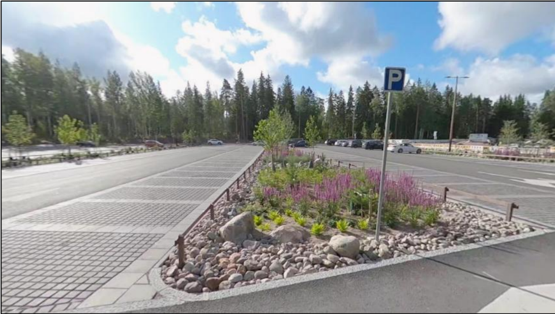
Kuva 28 Vantaan Kuusijärven pysäköintialueen vettäläpäisevät pysäköintiruudut ja pysäköintikampojen väleihin toteutetut biosuodatusalueet paikoitusalueen hulevesien puhdistamiseksi (Google Maps Streeview, 2023)
