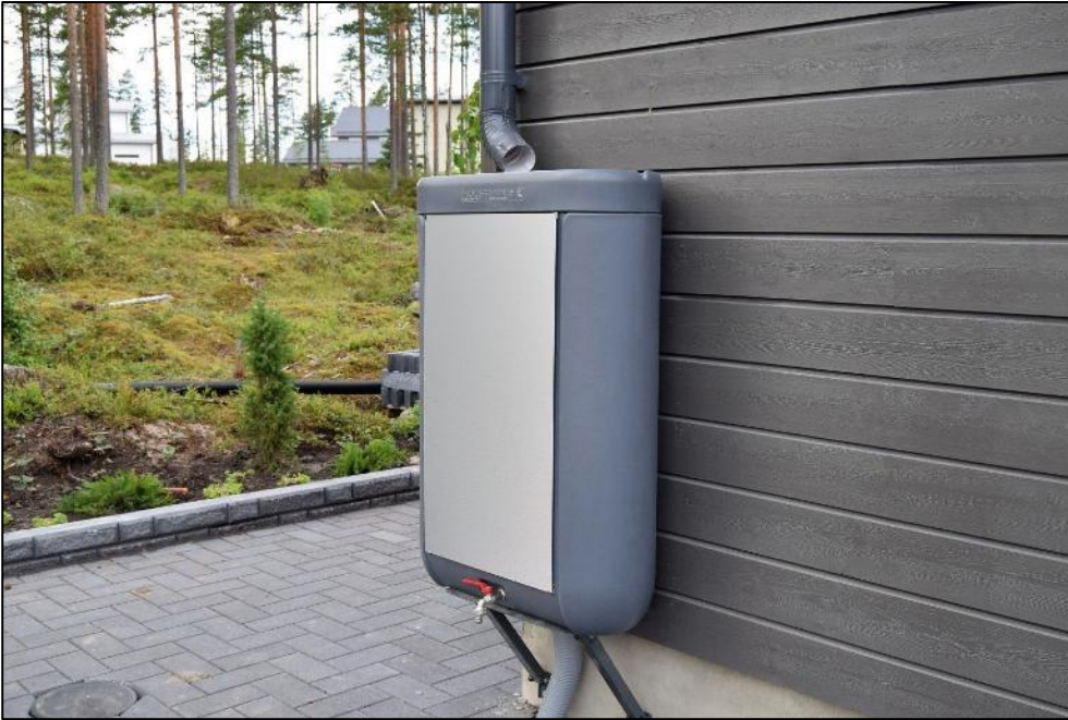
Kuva 27 Esimerkki kattovesien sadevesikeräimestä, josta vettä voi ottaa kastelukäyttöön (Houseman Oy, https://houseman.fi/vesitasku )
