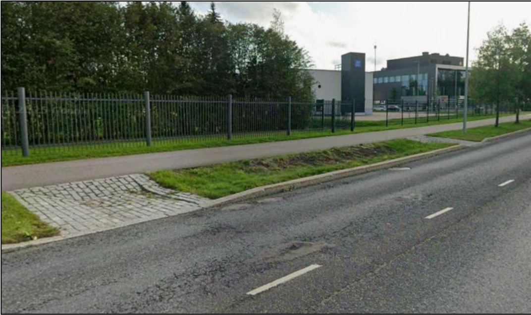
Kuva 30 Ajoradan hulevesien biosuodatusta Vantaan Meiramitiellä (Google Streetview)
