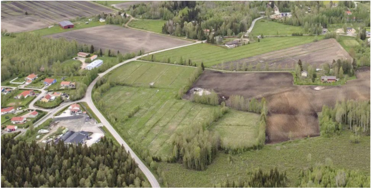
Kuva 10: Viistokuva suunnittelualueesta. Avoimia peltonäkymiä avautuu paikoitellen Monnilinjan varresta. Tien varressa nuori puusto peittää osin maisemaa suunnittelualueen suuntaan
